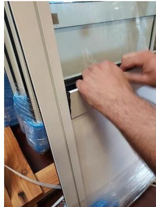
**3 Lors de la remise en place du capot, vérifier que la barrette PVC soit bien clippée. Puis reclipper le capot et remplacer le joint à bourrer de chaque côté.**
