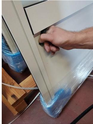
**2 Utiliser une main de levage pour faire basculer le capot et le déclipper. (Attention de ne pas marquer le remplissage, surtout si c'est un panneau)**
